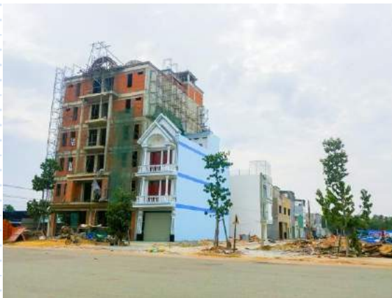
Hình ảnh công trình đang xây dựng
